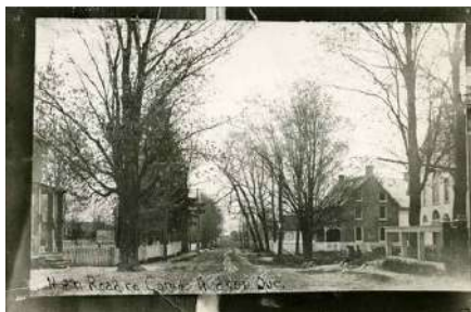
On aperçoit une petite partie du bâtiment (à gauche de la photo) sur cette photographie datant de 1930. BAnQ, P748S1P2926
